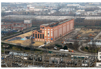
DR - La centrale EDF en cours de démolition
